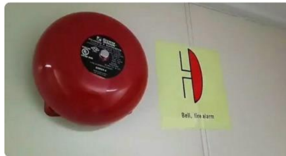
Gambar 3.4. alarm kebakaran yang dapat memberikan tanda bahaya kebakaran kepada seluruh penumpang di atas kapal
