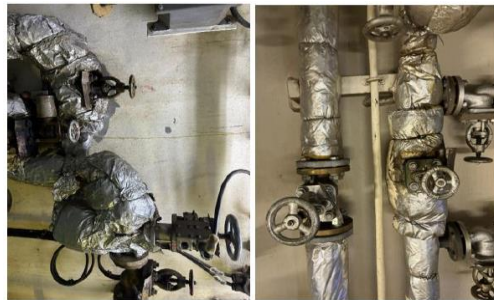
b. Insulasi pipa baik
