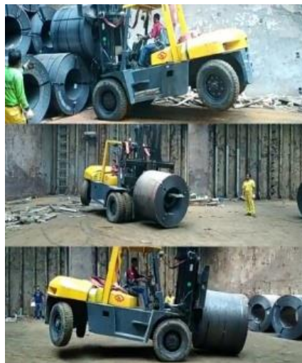
Gambar 3. Kondisi forklift yang tidak mampu menahan beban besi koil
