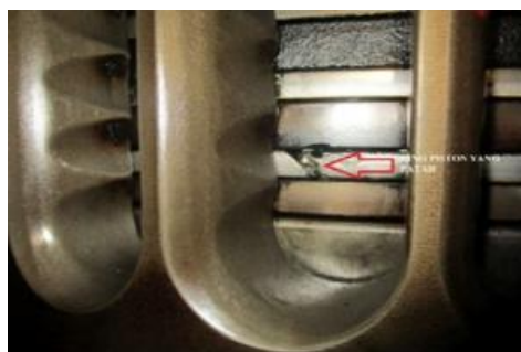
Gambar 3. Patahnya ring piston yang terjadi pada silinder nomor 3
